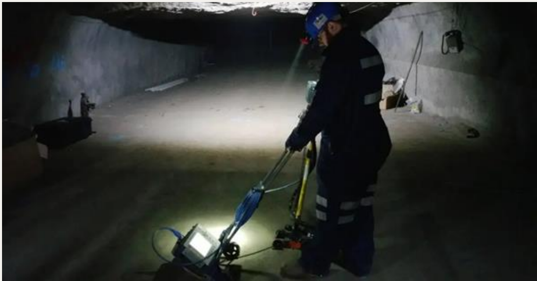
شكل 5: مثال على استكشاف منجم باستخدام الرادار المخترق للأرض (المصدر: gp-radar)
