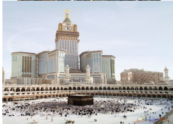
الشكل (4-5) برج الساعة والهلال المصنوع من ألياف البوليمر
